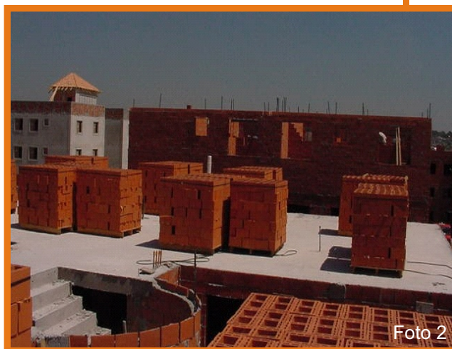
Fotos 1 e 2: Canteiro de obras de uma construção em alvenaria estrutural com blocos cerâmicos.
