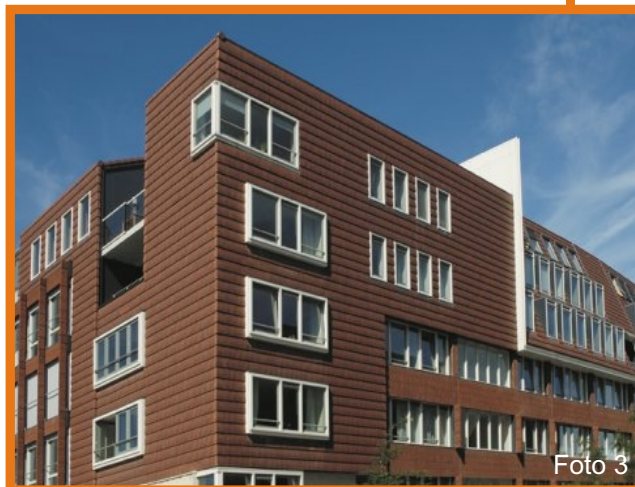
Foto 3: Edifício em alvenaria estrutural de blocos cerâmicos em Amsterdã / Holanda.
